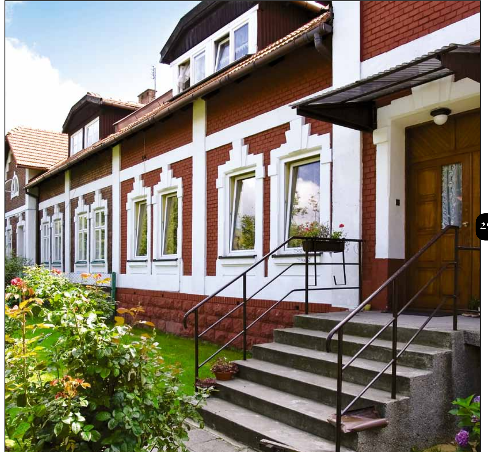
Brzeszcze: Kolonia Urzędnicza | The Office Settlement | Die Amtsansiedlung
